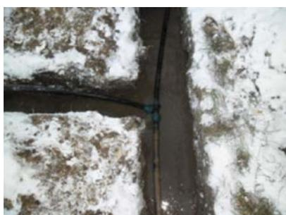
Die Bewässerung der Gewächshäuser ist inzwischen unter der Erde verlegt, so dass ein Einfrieren der Rohre vermieden wird.
