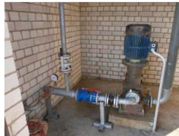
Mit Hilfe einer 15 KW Pumpe können die Felder bewässert werden.
